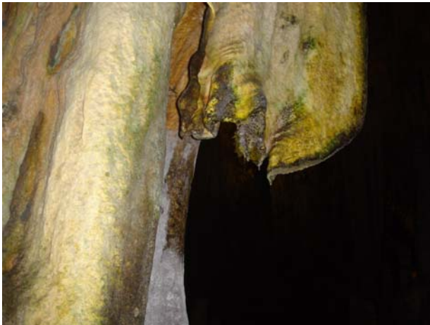
Foto N. 02 – A formação mostrada à esquerda na foto apresenta a superfície ressecada, muito provavelmente devido ao forte calor gerado no projetor com lâmpada vapor metálico de 400 W instalado logo abaixo. O calor gerado na lâmpada do projetor se transmite por condução ao corpo do aparelho e, depois por radiação e convecção, até a superfície referida, forçando a evaporação da água (umidade superficial) e ressecando a superfície.
